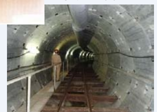
堀川左岸雨水調整池 工事中の写真
