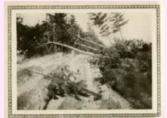
三階橋堤防破壊
