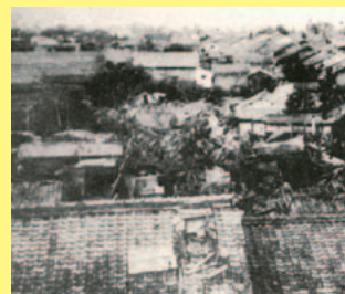
名古屋市清水町震害
